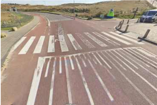
Zuidschinkeldijk oversteek fietsers bij strand-opgang herzien. Blokmarkering is voor fietsers in de voorrang! – FB#9
