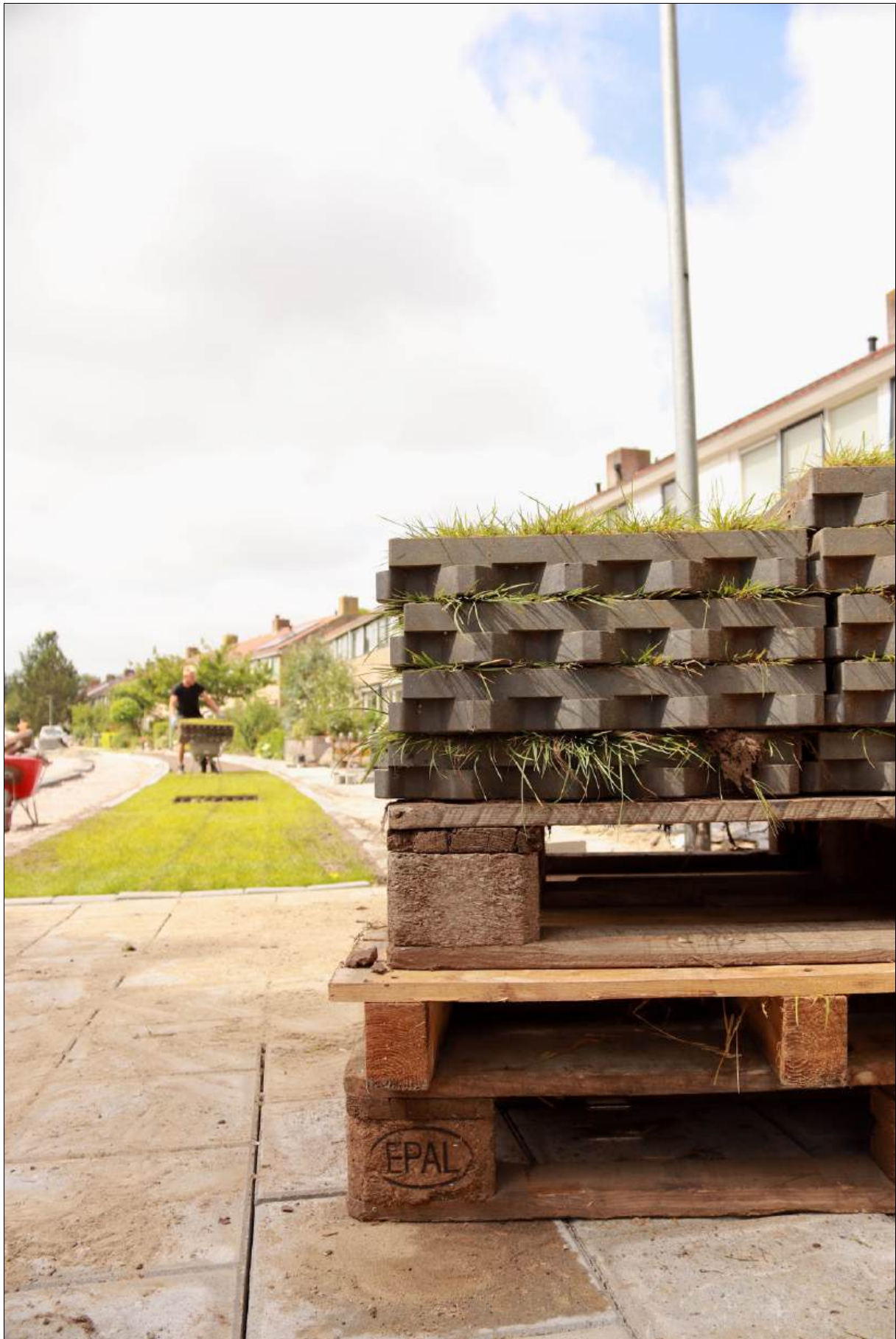
Aanleg groene parkeerplaats in Wieringerwerf
