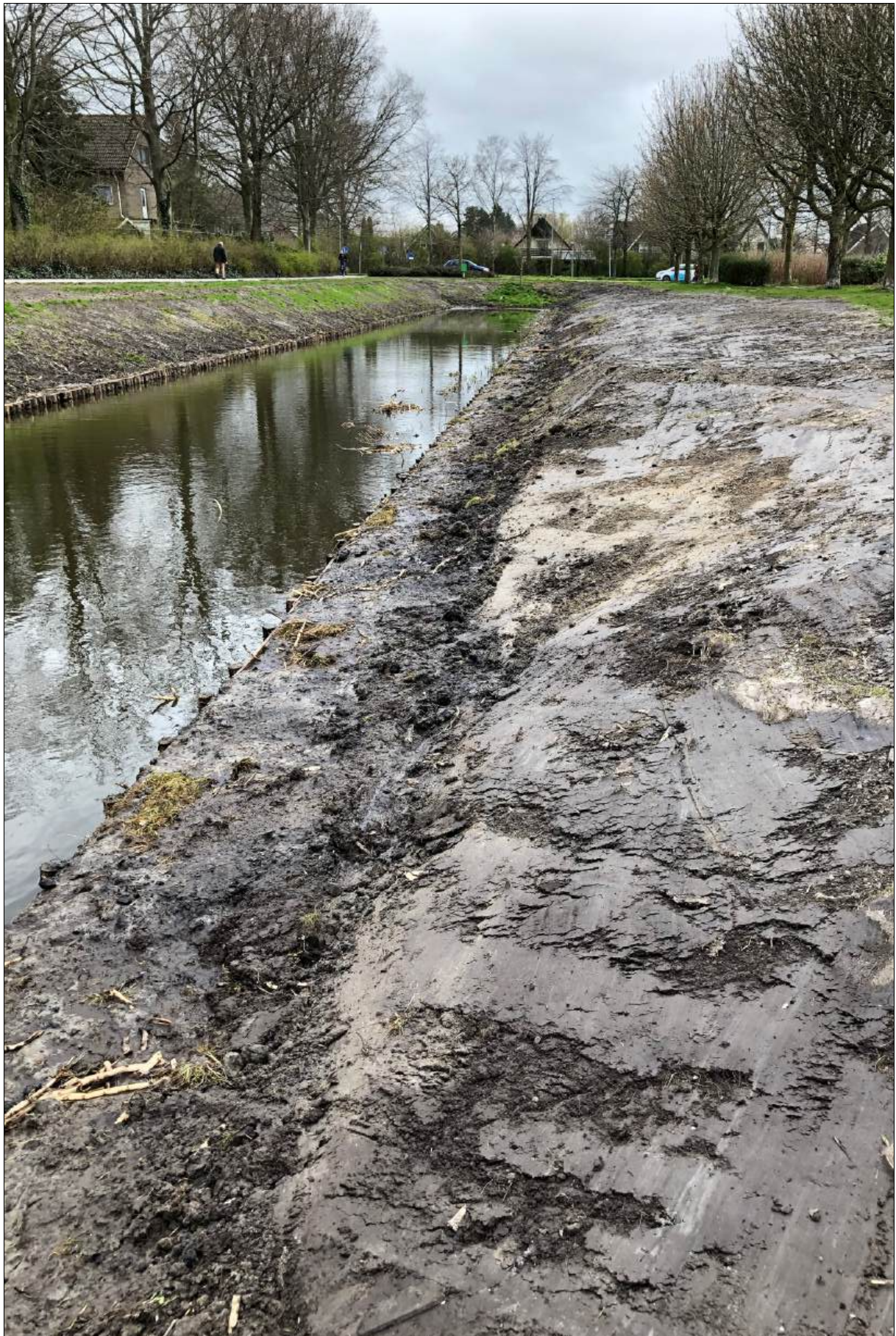
Nieuwe beschoeiing met plasberm in Wieringerwerf
