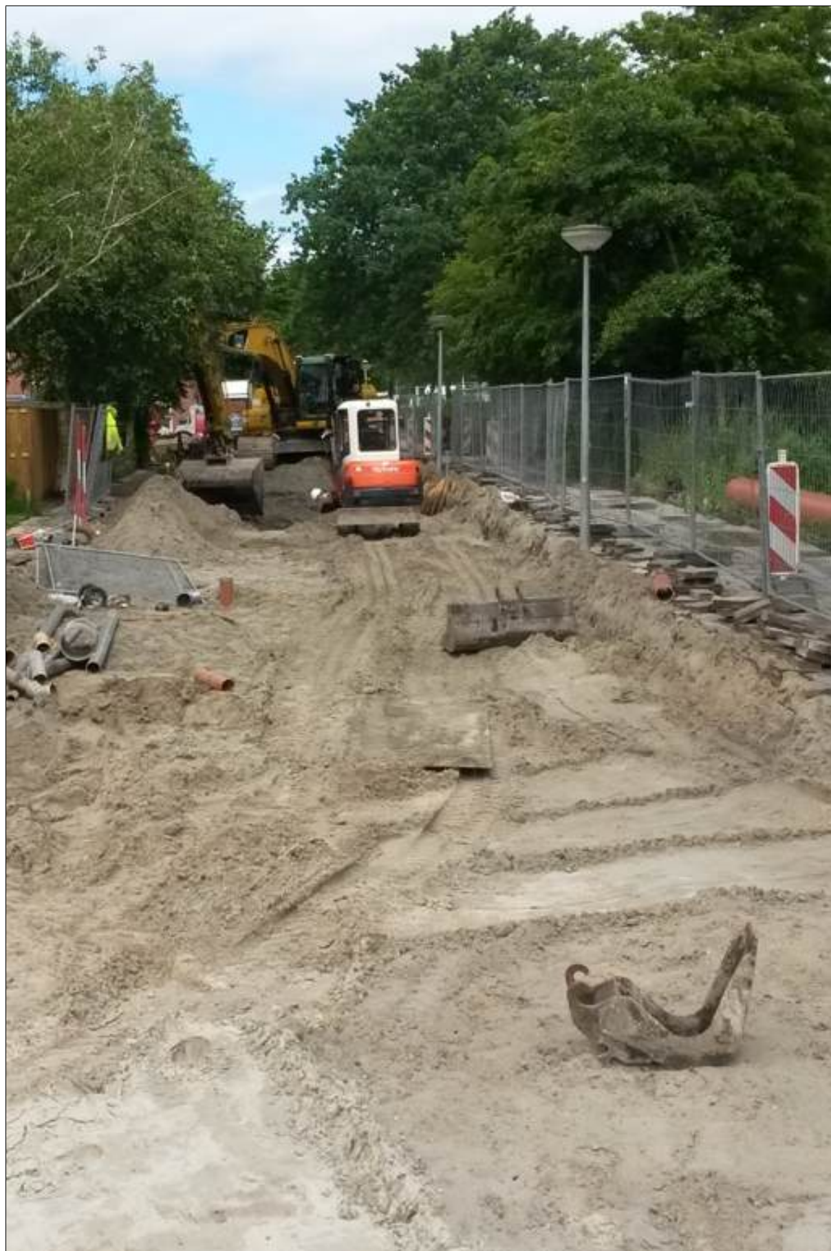
Vervanging van riolering in de Populierenlaan in Wieringerwaard
