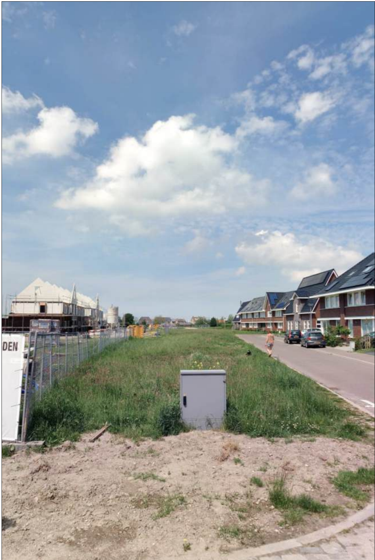
Nieuwe stroomkast openbare verlichting in Elshof Zuid Anna Paulowna (bron: CycloMedia Technology B.V.)
