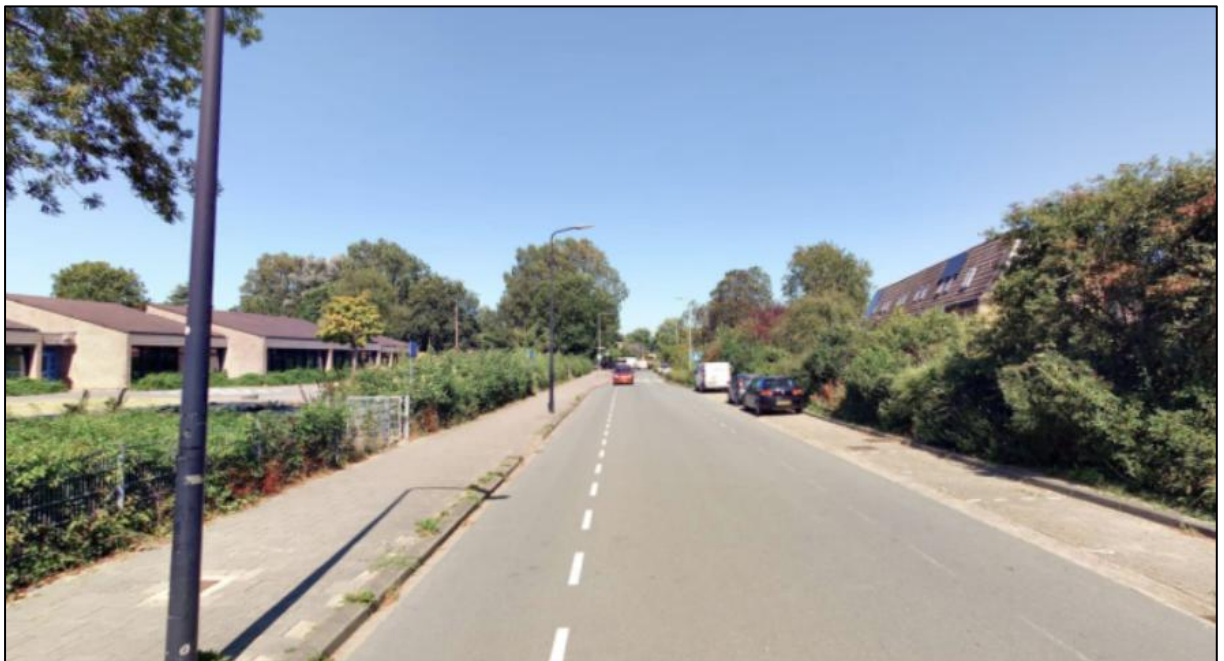
Figuur 2-3 Breed wegprofiel met fietssuggestiestroken op de Kievitlaan (bron: Cyclomedia).
